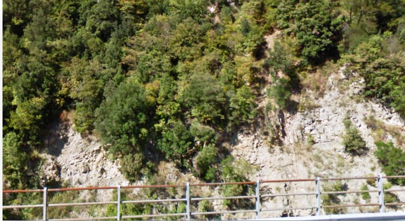
Formazione di M. S. Arcangelo (FMSb). Loc. Remolente, dal viadotto della S.S.691
